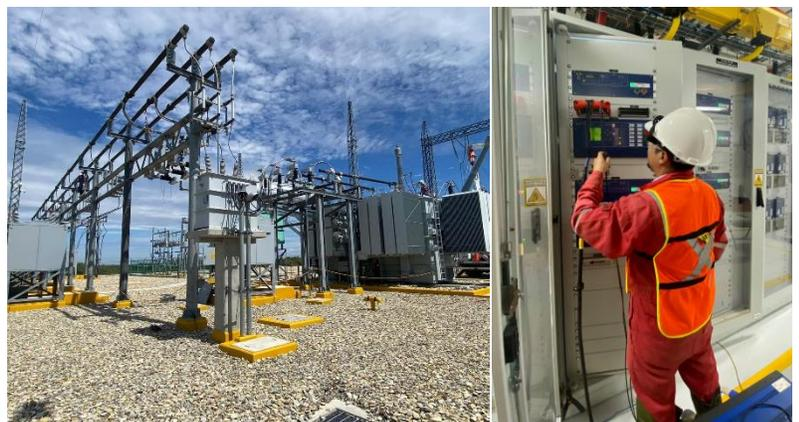
✦ Puesta en servicio de secciones PCYM y pruebas PreSAT - SAT en subestación encapsulada de 115KV. REFINERÍA DOS BOCAS Subestación encapsulada en SF6
