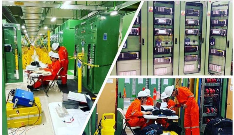
✦ Puesta en servicio de secciones PCYM y pruebas punto a punto (Satelitales) de la Subestación Nisuc (115kv), ubicada en el estado de Quintana Roo.
