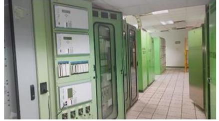
✦ Pruebas de protecciones a relevadores de generación en la subestación Tula de la unidad generadora 4. En una tensión de 34.5kva a 230kva con capacidad de 20MVA
