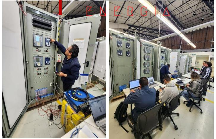
✦ Puesta a punto y en operación de tableros de protección, control y medición para la ampliación de las subestaciones COMALCALCO, CARDENAS UNO, CHONTALPA, JALPA DE MENDEZ, TULIPAN, REFORMA, POCHUTLA, MOTOZINTLA, dentro del ámbito de la División de distribución sureste.
