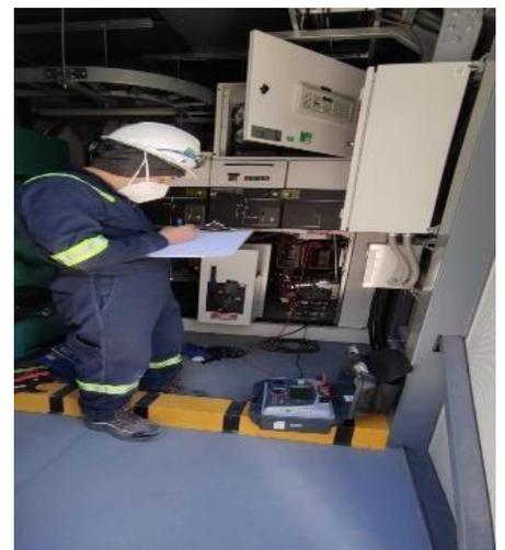
⚡ Reemplazo en licencia de relevador REF615 Reemplazo en licencia de relevador REF615 en circuito colector de planta Horus Solar Pruebas de protecciones de funciones ANSI 50/51 50N/51N 27/59/81 Reapriete en todos los tableros PCYM existentes de S.E. ELEVADORA
